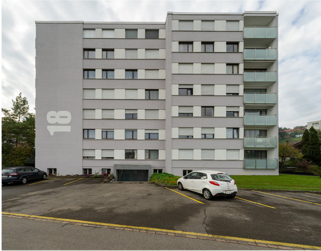
Strohackerstrasse 18, Blick Richtung Westen
